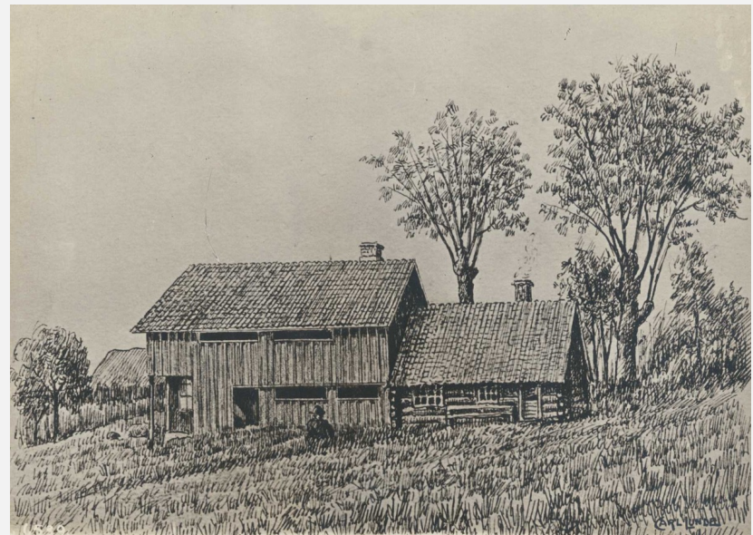
Det eldste bilde av bebyggelse på Høvik er en litografi fra Bærumsboka (hovedhuset på gamle Nordre Høvik (Østre Høvik, nedre stue), Skaugum-åsen i bakgrunnen Lå i svingen i overgangen mellom Høvikveien & Snøveien
